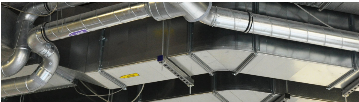
Abb. 1: Beispiel zur Kennzeichnung von Luftleitungen mit der geförderten Luftart und Luftströmungsrichtung (Wolf Rienhardt)
